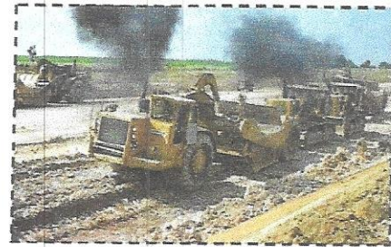
Chantier LGV Tours-Bordeaux
